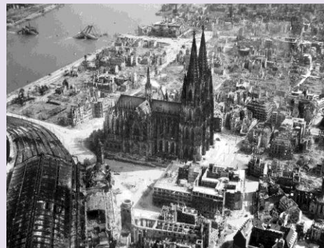
De bombardementsschade door de oorlog
